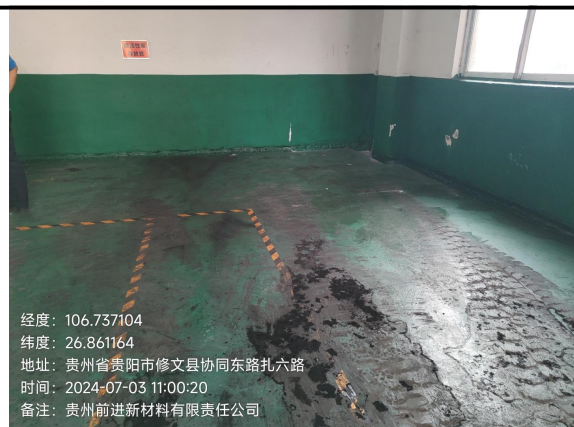
2号危险废物暂存间防渗
