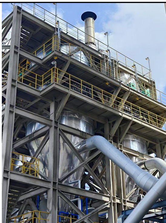
废气袋滤器（只起收集炭黑的作用，不外排）
